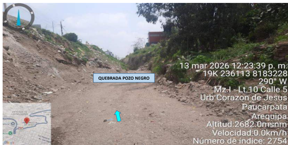
IMAGEN 02: EN ESTE TRAMO SE OBSERVA EN AMBAS MÁRGENES DE LA QUEBRADA POZO NEGRO, SE ENCUENTRA SIN PROTECCIÓN, Y SU CAUCE SE ENCUENTRA COLMATADO DE SEDIMENTO; Y EXISTEN VIVIENDAS CERCA A SU CAUCE.
